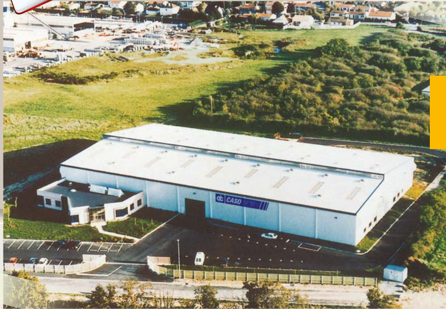
Le site de Caso à Nantes vers 1980.
