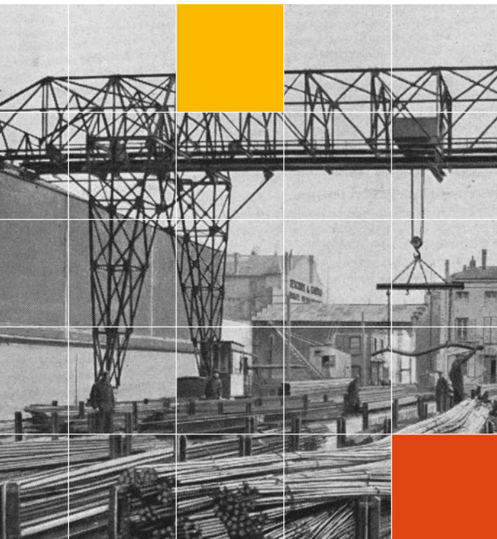
Le parc à poutrelles de l'agence de Roanne, au début du XX e siècle. En 2012, l'agence est toujours à la même adresse.
